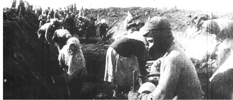
Работы на строительстве оборонительных укреплений у г. Орджоникидзе. 1942 г.
